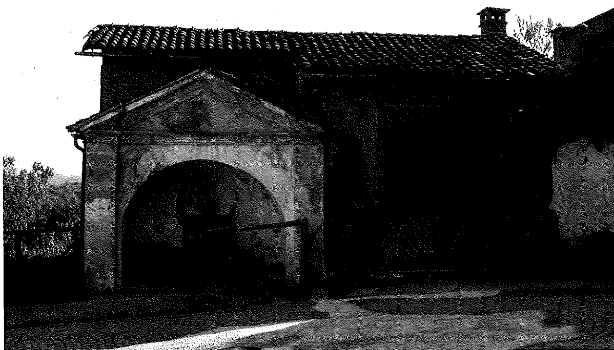
Vista della cappella oggetto di intervento
