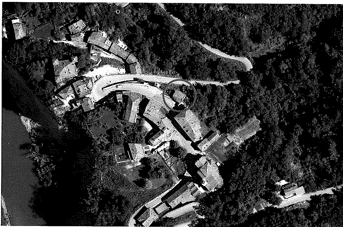
Vista aerea dell'edificio oggetto di intervento
