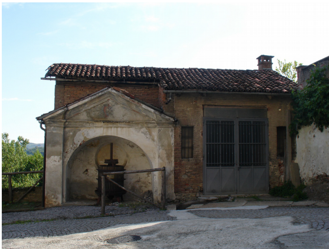
Foto 1 – Vista frontale del fabbricato oggetto di intervento
