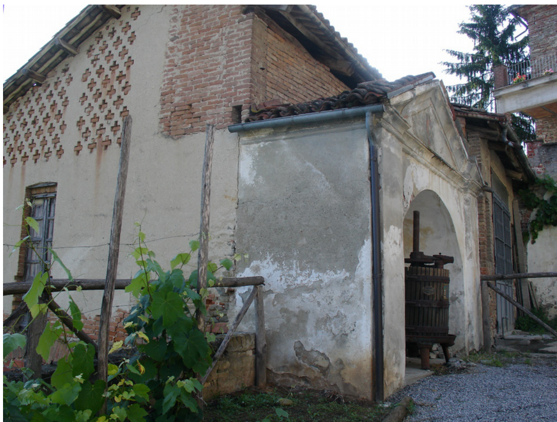
Foto 2 – Vista laterale del fabbricato oggetto di intervento
