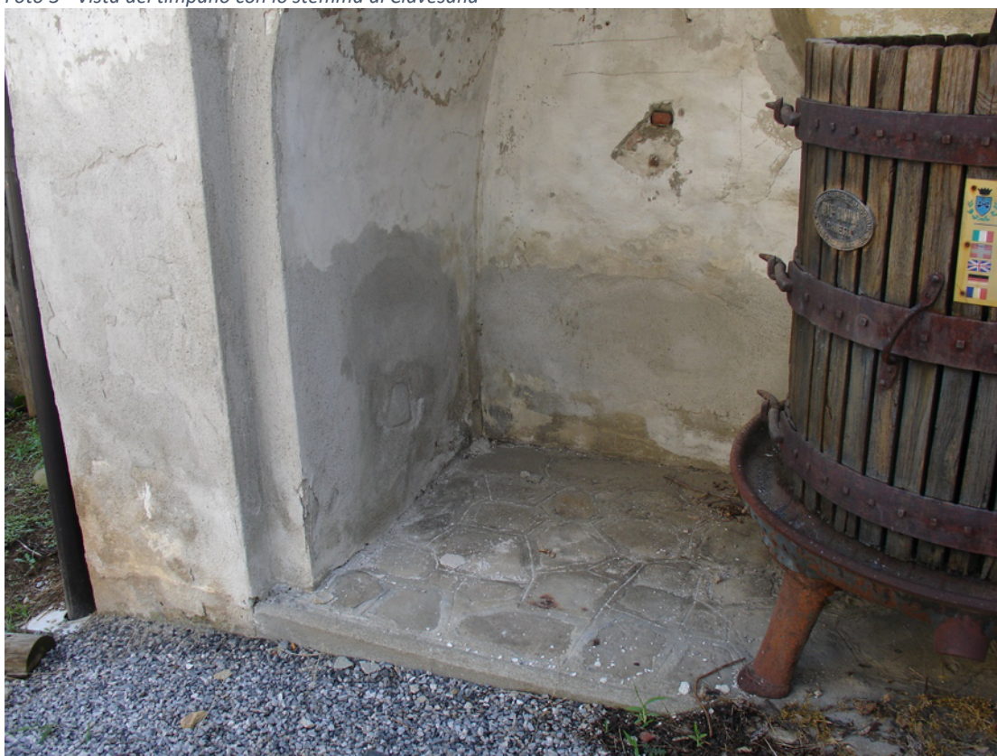
Foto 4 – Vista della pavimentazione
