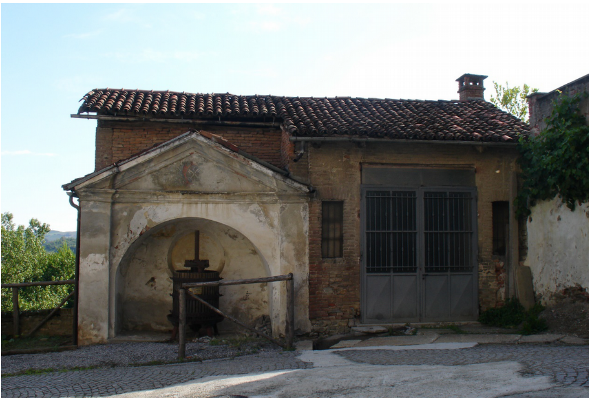
Foto 5 - Vista della cappella oggetto di intervento
